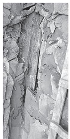
ruktion massiv beschädigt sind. Eine akute Einsturzgefahr besteht zum Glück nicht. Nach Abschluss der umfassenden Voruntersuchung, an der Sachverständige für Holzschäden und für Dachkonstruktionen beteiligt waren, wird aus baulicher und wirtschaftlicher Sicht eine komplette Dachsanierung empfohlen.
