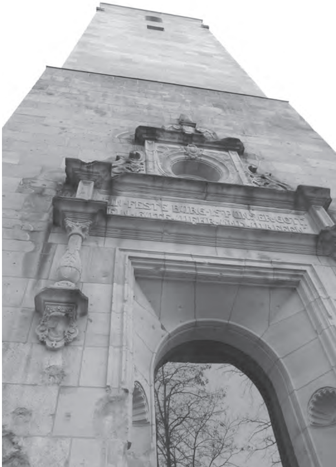
Blick auf den Lutherturm
