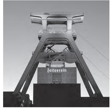
Schacht 12 des ehemaligen Zeche Zollverein
